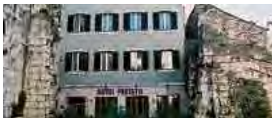
Hotel Peristil Split (Croazia)
